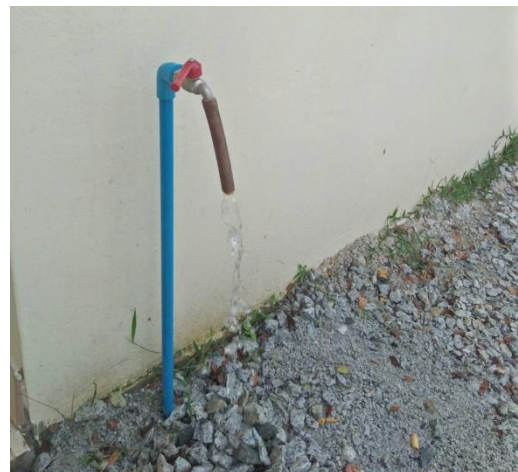
การติดตั้งระบบนํ้านอกอาคาร
