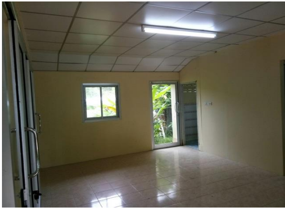
ทาสีและติดตั้งระบบไฟในอาคาร
