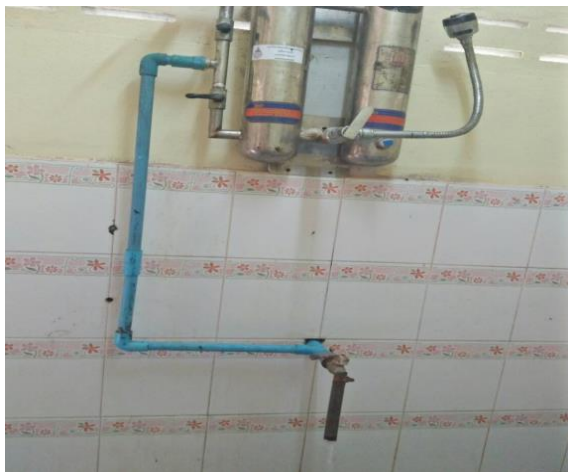
ซ่อมแซมและติดตั้งระบบน้ำเพิ่มเติมในอาคาร
